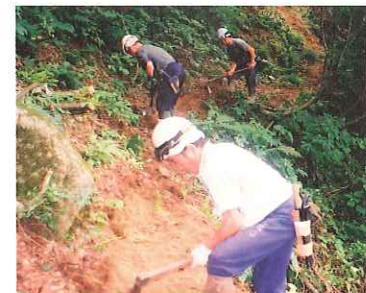
新ルート開削作業
