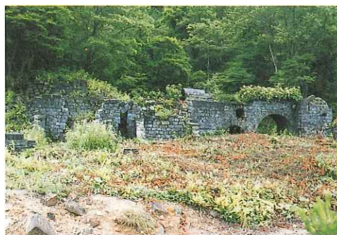
からみ煉瓦で造られた煙道(水沢鉱山)
