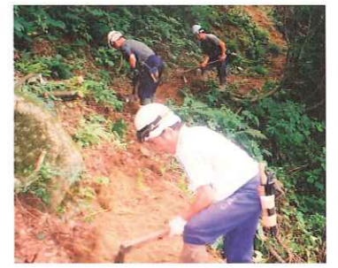
新ルート開削作業
