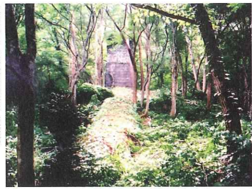
大荒沢銅山製錬所の煙道と煙突跡
